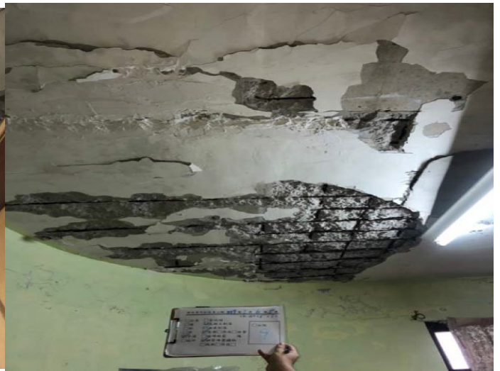
圖13 建物現況照片 (2)
