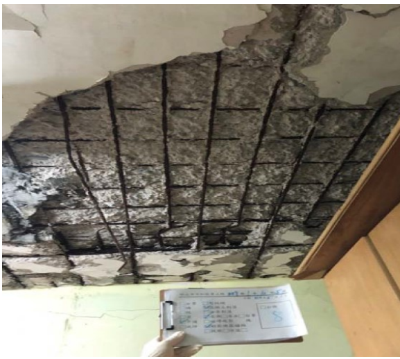
圖12 建物現況照片 (1)
