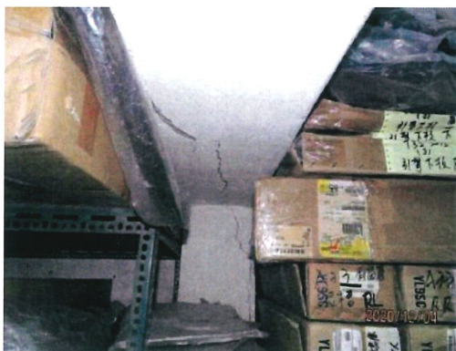
圖16 建物現況照片(1)
