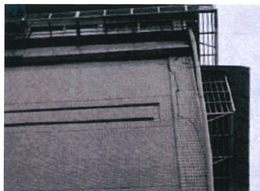
圖17 建物現況照片(2)
