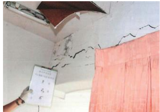
圖 9 建物現況照片(2)
