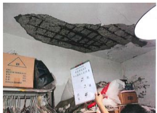
圖 11 建物現況照片(4)
