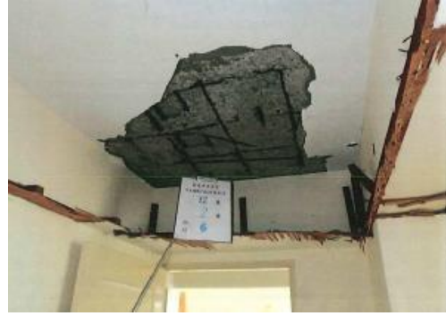
圖 13 建物現況照片(6)
