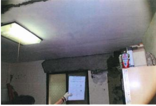
圖 12 建物現況照片(5)
