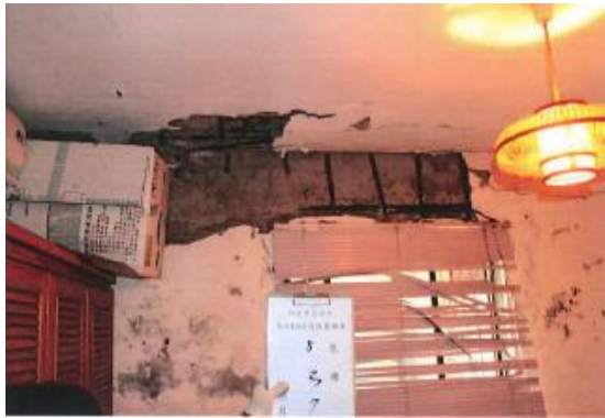
圖 8 建物現況照片(1)
