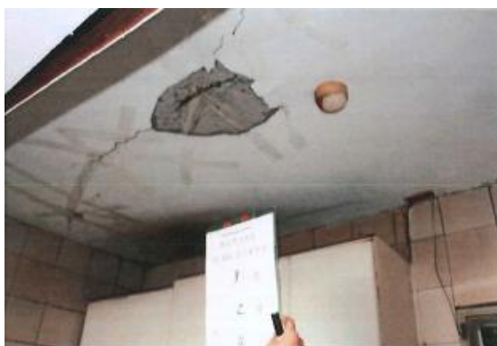
圖 10 建物現況照片(3)
