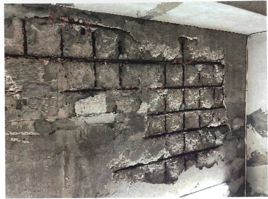
圖13 建物現況照片(6)
