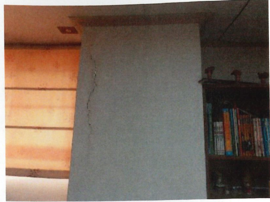
圖11 建物現況照片(4)
