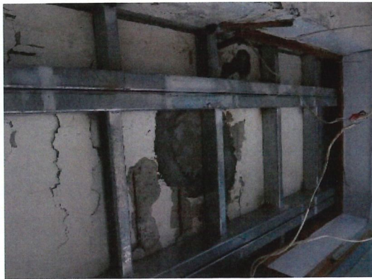
圖12 建物現況照片(5)
